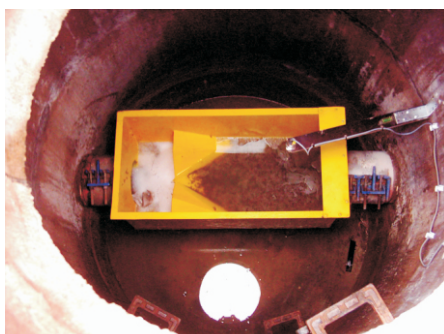
Na zdjęciach poniżej zabudowane w studzienkach z PE i studzienkach betonowych zwężki KAMA 1 Zakres pomiaru od 0 do 150m 3 /h
