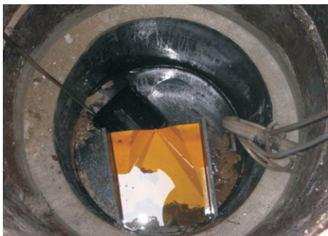
Na zdjęciu po lewej stronie: studzienka hybrydowa, dolna część wykonana z PE z wbudowaną zwężką KAMA 1, górna część studni to typowe kręgi betonowe.
